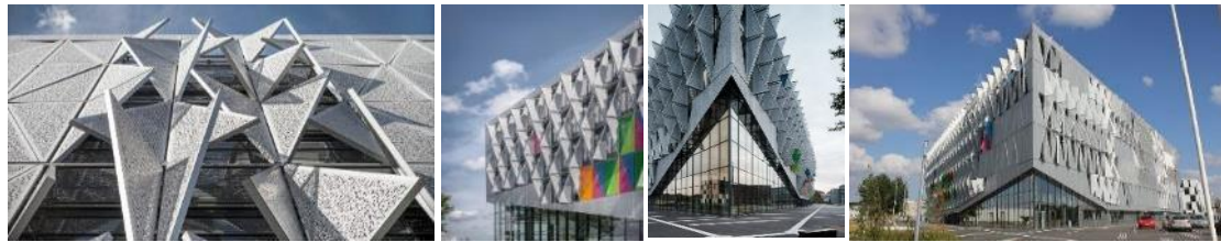
شكل (26) الواجهات الخارجية المتحركة التي صممت على شكل مظلات مثلثة لتتناسق مع شكل المبنى.
