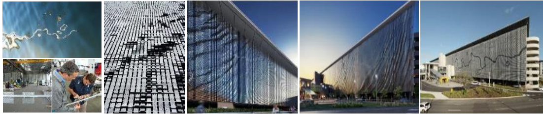
شكل (30) واجهة حركية مكونة من ثمانية طوابق تنشط الرياح 117000 لوح ألومنيوم معلق تظهر أنماط الضوء والظل. المصدر: https://www.uancomnanv.com/studio/brisbane-airport
