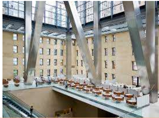
شكل- ١٨: الاحتفاظ بالغلاف الخارجي مع تدعيم الفراغ الداخلي بالعناصر الانشائية المعدنية
