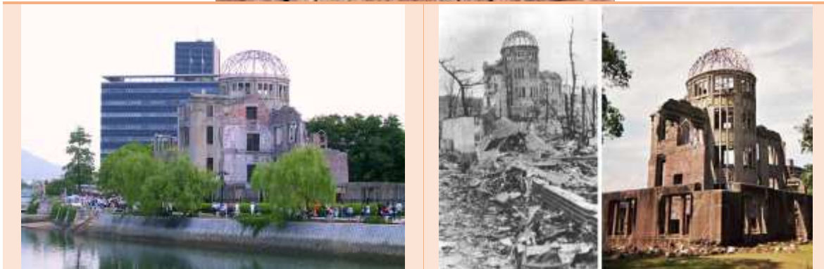
شكل رقم ٥-: مبنى قبة هيروشيما قبل التدمير وبعدها التدمير وبعدها التدمير وبعدها التدمير وتوظيفه كمزار سياحي [٢٠]
