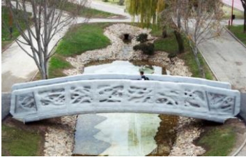
شكل (6) صورة لجسر المشاة المطبوع بتقنية الطباعة ثلاثية الأبعاد للمباني في أسبانيا. المصدر (4)
