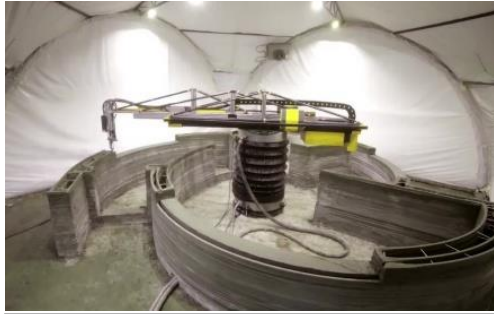
شكل (3) يوضح الطابعة ثلاثية الأبعاد و طريقة عملها داخل خيمة. المصدر (5)
