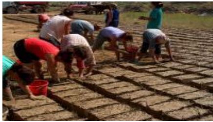
شكل (1) التقنية اليدوية لتشكيل الطين النئى في قوالب من الخشب. المصدر(3)
