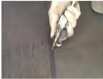
شكل (2) يوضح تنظيف سطح الخرسانة تماما من أجزاء الخرسانة الضعيفة أو المفككة أو زيد الأسمنت. المصدر : 12
