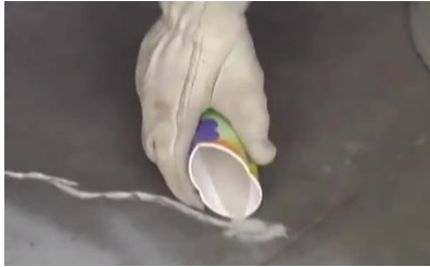
شكل (5) يوضح ملئ الشروخ بالرمل بعد حقنها بمادة Spall TX عدة مرات متتالية. المصدر : 12
