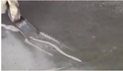
شكل (6) يوضح أنه يتم ضغط ومساواة سطح الرمل بعد ملئ الشروخ به بحيث يتم التماسك بينه وبين المادة المستخدمة والخرسانة. المصدر : 12
