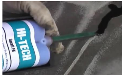
شكل (7) يوضح استخدام Spall TX بعد ملئ الشروخ و دمكها بالرمل لمزيد من التماسك. المصدر : 12 .
