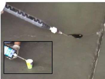
شكل (3) مادة Spall TX بعد سحبها بسرّجة مخصصة لحقن الشروخ الخرسانية. المصدر : 12:
