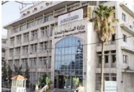
شكل (12) استخدام الكاسرات الرأسية فى مبنى وزارة الصناعة والتجارة [10] .
