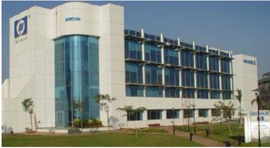
شكل (11) استخدام الكاسرات الافقية في مبنى HP بالقاهرة الذكية بمصر [19] .
