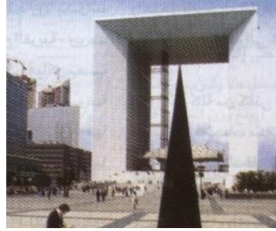
شكل (27) يوضح مبنى الأرش الكبير، فرنسا. المصدر: مجلة عالم البناء، عدد رقم 183، ص:27.
