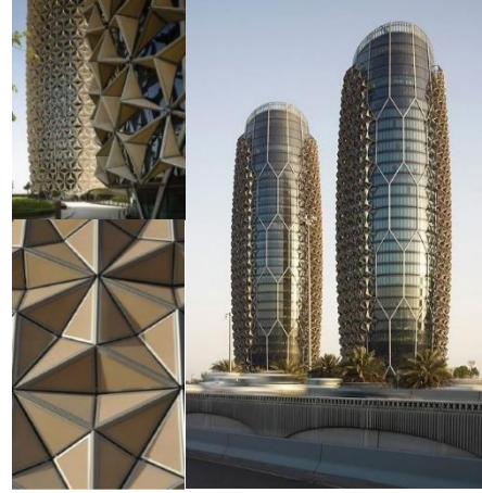
شكل (١٧) تصميم الواجهة الحركية المستجيبة لحركة الشمس باستخدام برنامج Rhinoceros Grasshopper، المصدر: آلاء رفيق سالم مكي " آليات تطبيق متطلبات العمارة الذكية عمى المباني الإدارية"
