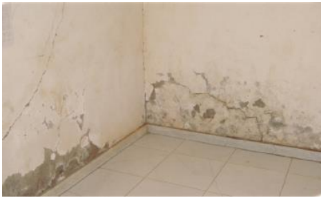
شكل ٧: تلف مواد التشطيبات الداخلية نتيجة ارتفاع منسوب المياه الجوفية المصدر: ايمان محمد عبد الغفار، أثر العوامل البنائية في المباني، رسالة ماجستير، جامعة السودان، ٢٠١٥، ص ٥٤
