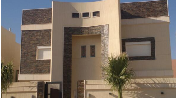
شكل ١٣: يوضح البروز بكتل من المبنى لتظليل الواجهات، المصدر: [ https://shop.onlineoutlet2021.ru/ ] (Accessed 11/11/2021 at 8:33 PM)
