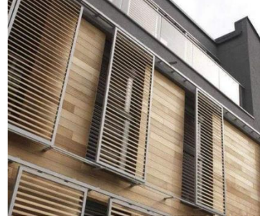
شكل ١٢: يوضح استخدام كاسرات الشمس لتظليل الواجهات، المصدر: [ https://www.facebook.com/united.engineers.f.or.constructions/photos/pcb.199120977432739/4/1991209720994066/ ] (Accessed 19/11/2021 at 7:33 AM)
