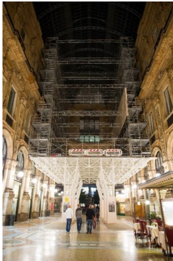
شكل (١٠) يوضح السقالات المتحركة المصدر:
