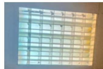
أ) وحدة الاضاءة المستخدمة في المبنى
