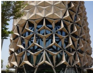
شكل (5-2) يبين الواجهات المتحركة والقدرة على التحكم بفتحاتها - مبنى المقر الجديد لمجلس أبوظبي للاستثمار - برج البحر
