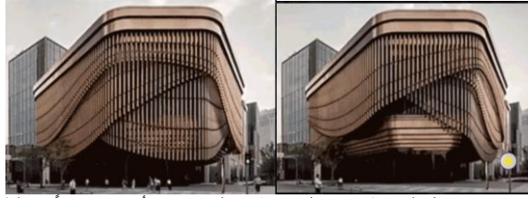
شكل (3-2) يبين تغيير شكل الواجهة من خلال حركة دخول وخرج الأجزاء تفاعلاً مع الظروف المناخية Source: www.Lumenhaus.com/desings/index.htm. (Accessed 20/9/2024)
