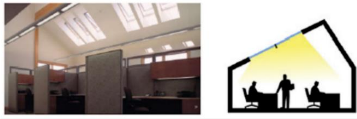
شكل (8-1) يوضح نظام Skylights لتوفير الإضاءة النهارية
